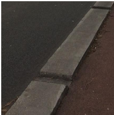
Figuur 3 - verhoogde wegmarkering van beton
